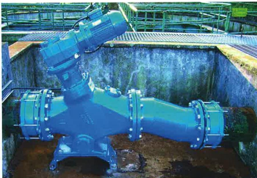
Vue d'un Mono TR Muncher installé dans une station d'épuration pour broyer les solides contenus dans les eaux usées et prévenir les blocages de pompes.
