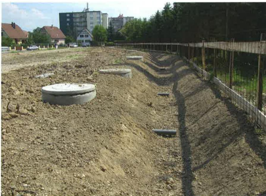
Illustration 5: Raccordement de différents trop-pleins de cuves d'eau de pluie dans une noue d'infiltration.
