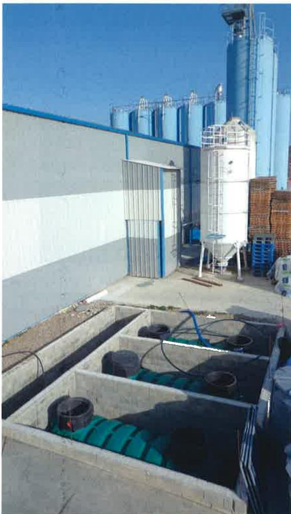
Installation de trois cuves en série de récupération d'eau de pluie (PEHD) d'un stockage total de 30 m<sup>3</sup> pour le refroidissement d'un procédé de fabrication et de nettoyage d'équipements de fabrication et d'entretien. Réalisation Sebico.
