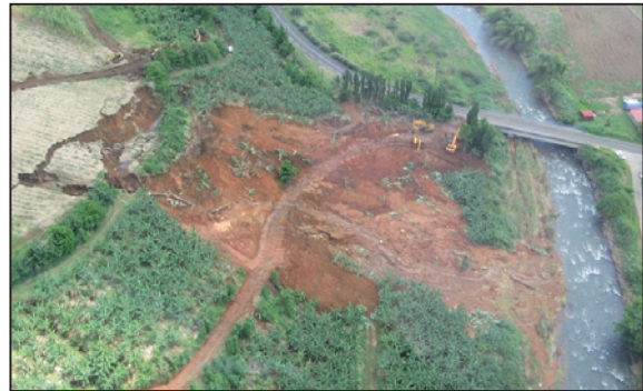
Figure 1. Glissement de Séguineau (mai 2009), casse de canalisation Ø 800 mm
