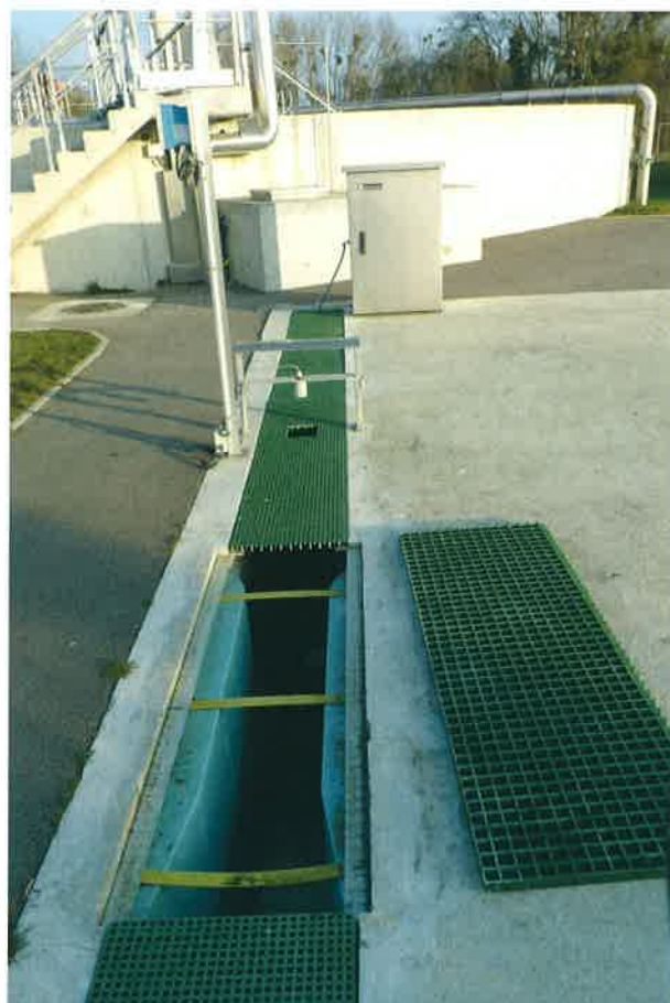
Endress+Hauser propose six standards de Venturi préfabriqués en fibres de verre et résines polyester, avec gelcoat. Chaque Venturi est fourni avec sa réglette graduée pour lecture du débit Q = f(h) . Le plus petit affiche un débit nominal de 30 m 3 /h pour un débit maximum de 42 m 3 /h. Le plus important accepte 1 476 m 3 /h en débit nominal pour 2 200 m 3 /h en débit maximum.
