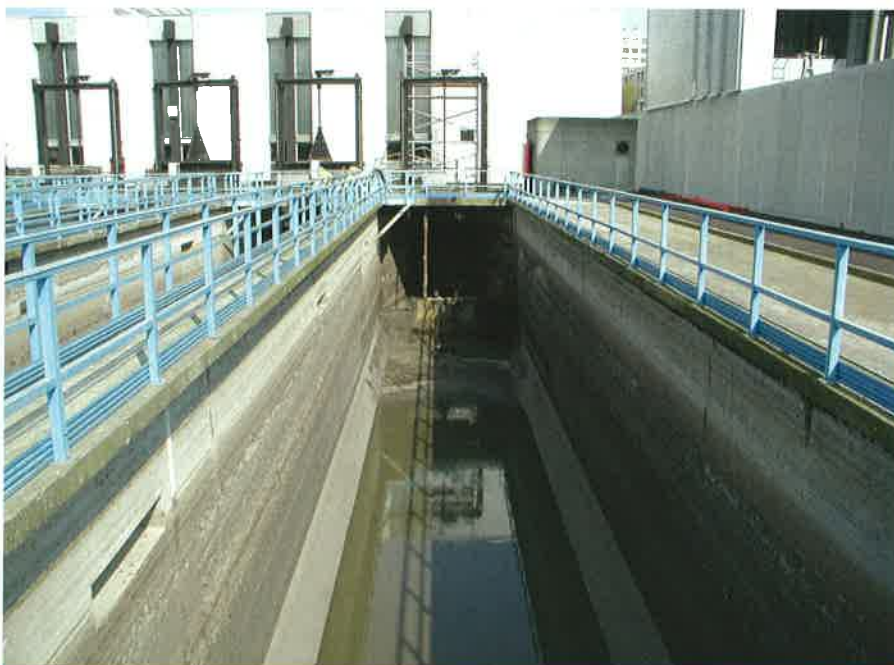
Mesure de débit sur dessableurs. Débitmètres UF 322CO - 3 cordes de vitesse
