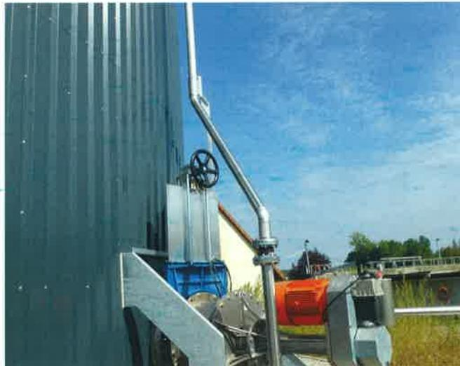
Photo 9 - Weyersheim (67) 30 000 EH - 1 Digelis™ Smart version SIMPLEX de 900 m<sup>3</sup> avec brassage mécanique.
