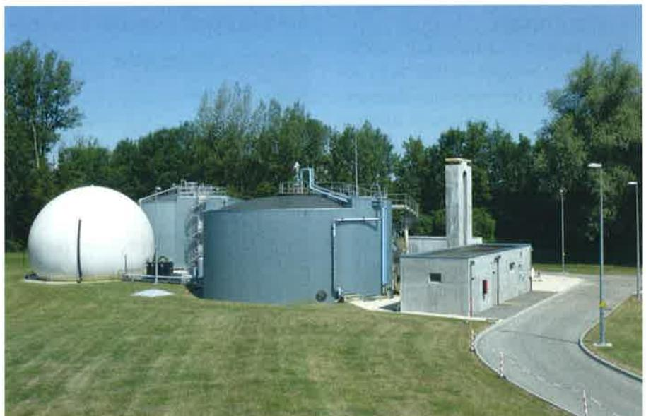
Photo 13: La Roche sur Foron (74) - 90 000 EH - 2 Digells™ pour un total de 2 200 m<sup>3</sup> - Unité de production de biométhane.
