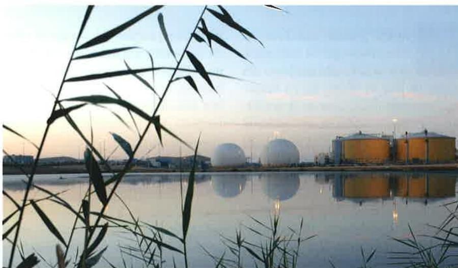
Photo 1 - As Amra, Amman (Jordanie) - 220000 EH - 4 méthaniseurs Digelis™ (64000 m<sup>3</sup> au global).
