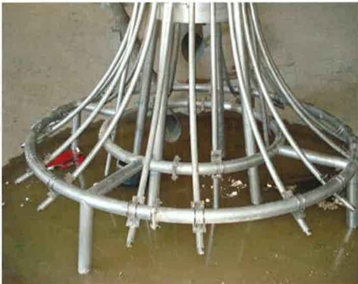
Photo 8 - Brassage au gaz - Cannes d'injection.
