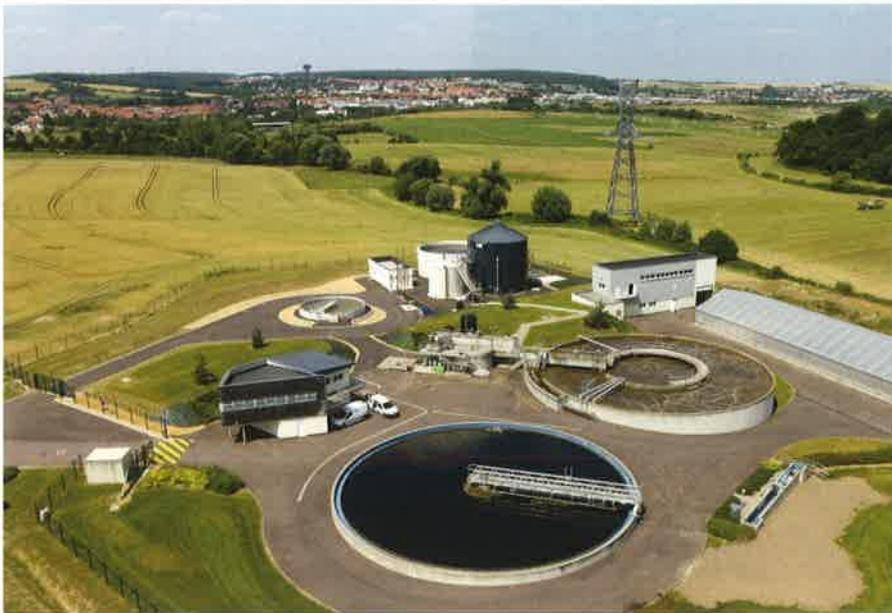
**Photo 10 - Folschviller (57) – Mise en place d'une décantation primaire et d'une méthanisation sur une usine existante.**
