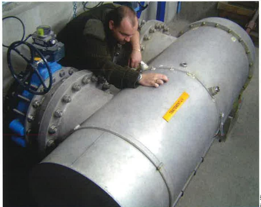
Les gammes IAM et DW de BIO-UV permettent de désinfecter l'eau brute (forages, captages, ...) et de garantir le respect des limites de qualité bactériologique de l'eau suivant le décret du 25/12/2003 avant distribution.
