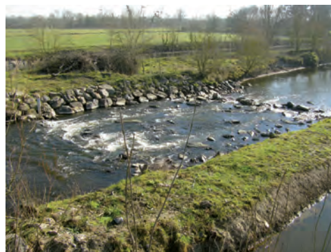
Rampe en enrochement sur l'Yon
