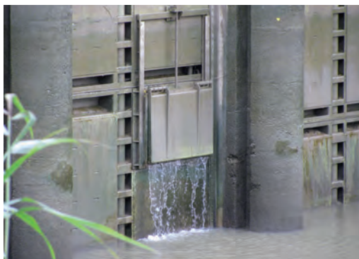
Vantelles sur l'ouvrage de Buzay
