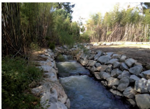
Bras de contournement sur le Lay
