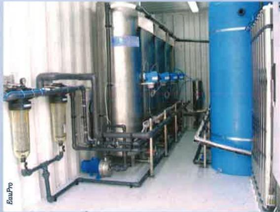
constructeur conseille un pré-traitement de la lagune pour augmenter la biodégradabilité des effluents, la réduction des consommables et la neutralisation des mauvaises odeurs. Baptisée Aquazone, la station est fixe ou mobile pour des interventions ponctuelles sur des sites, et permet de traiter des volumes de 30 à 60 m<sup>3</sup> par jour avec un rejet dans le milieu naturel
