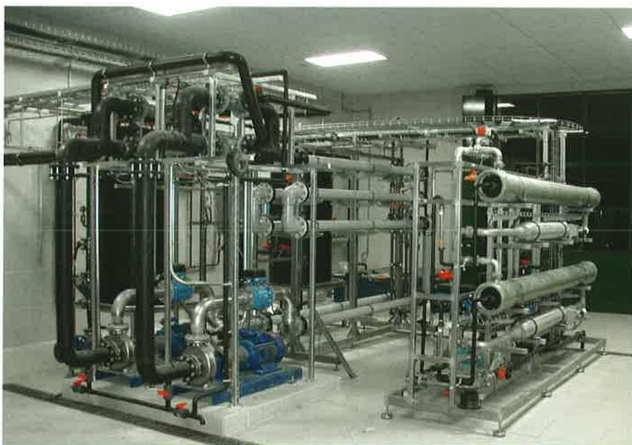
*Blomembrat' d'Ovive allie traitement biologique faible charge et séparation membranaire. Cette technologie permet par exemple de réutiliser des eaux traitées pour le lavage des camions citernes sur site.*
