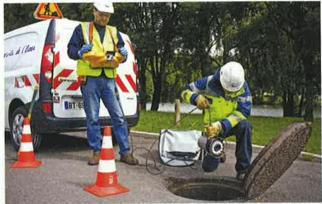
L'inspection visuelle ou télévisuelle implique le nettoyage préalable des réseaux par hydrocurage et est effectuée après réouverture des branchements.
