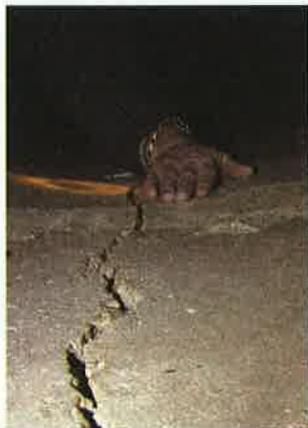
Le colmatage de fuites au niveau d'une fissure, d'un assemblage ou d'un raccordement fait appel à des techniques simples de fraisage, d'injection ou de chemisage partiel.
