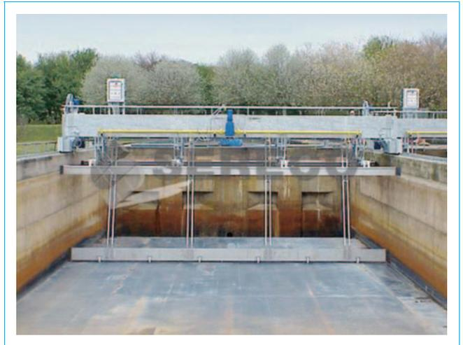
**Figure 11 – Décanteur rectangulaire avec racleur en « va-et-vient »**
