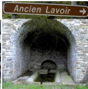
Vencimont - Ancien lavoir
