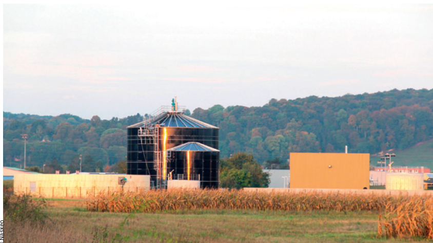
Unité de méthanisation en infiniment mélangé de Gaillon (27), d'une puissance de 725 kWél. Réalisation Naskeo Environnement (Groupe Keon).
