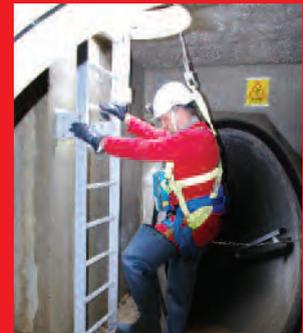
La plate-forme dédiée aux espaces confinés et à la sécurité en assainissement permet de s'initier et de s'entraîner en toute sécurité à l'intervention dans ce type d'ouvrage.
