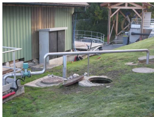
Figure 70 Conduite d'injection d'effluent urbain dans la filière hôpital
