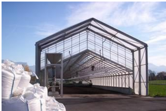
Figure 82 Serre de séchage des boues de la STEP de Bellecombe
