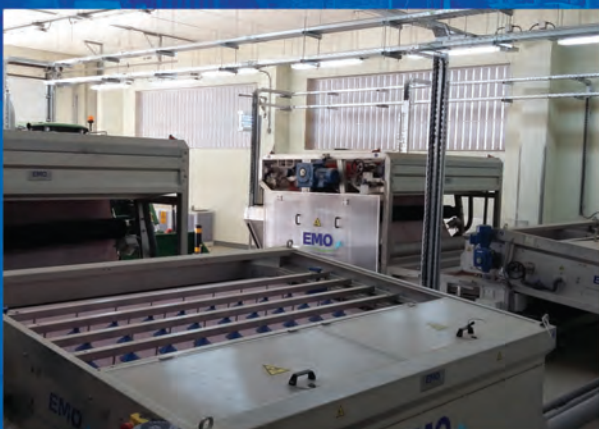
Installation sur site
