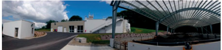
**SUEZ a su proposer une filière membranaire efficace à coût équivalent: voici l'exemple de Montours (35) avec une ultrafiltration directement sur eau décantée;**
