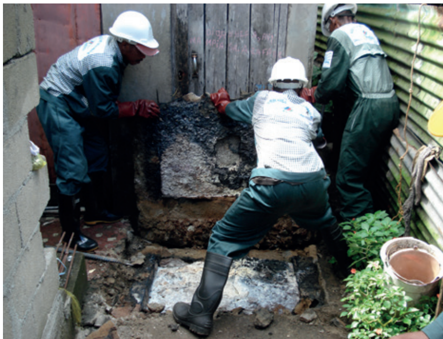
Ouverture de fosse septique.
