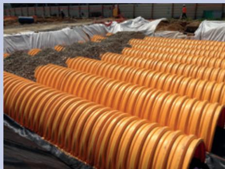
Les eaux pluviales s'écoulent jusqu'à un regard les menant au système de drainage souterrain composé de plusieurs tunnels qui se remplissent successivement grâce à un système de surverse. Elles peuvent ensuite être infiltrées dans le sol ou être évacuées grâce à un débit de fuite régulé dans les canalisations du réseau. La solution existe en cinq modèles de capacité croissante, avec un volume installé allant de 0,39 à 1,35 m<sup>3</sup>/m<sup>2</sup>.
