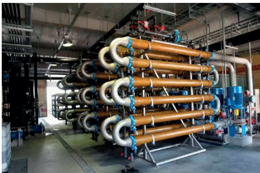
La technologie X-Flow Helix™ de Pentair permet de prévenir l'encrassement des membranes et de réduire de 20 à 50 % de la consommation d'énergie.
