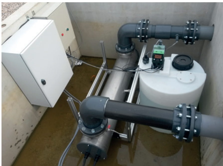
Comap a développé un important dispositif de recherche pour le traitement des micropolluants, basé sur un procédé d'oxydation avancée : UVc + peroxyde d'hydrogène (UV/H 2 O 2 ). Cette solution vise spécifiquement les Step de petite ou moyenne taille, de moins de 10 000 EH et peut aussi être utilisée pour le traitement des effluents industriels.
