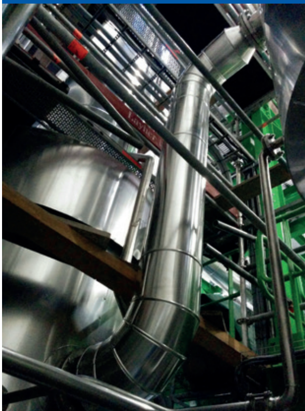
Unité de distillation et de fabrication de nitrate d'ammonium commercial à base d'ammoniaque issu du traitement du lisier de porc. Réalisation Exonia.
