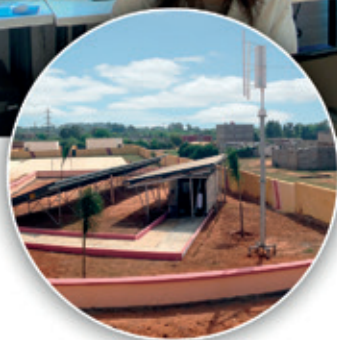
Unité de traitement d'eau de forage fonctionnant avec des énergies renouvelables.
