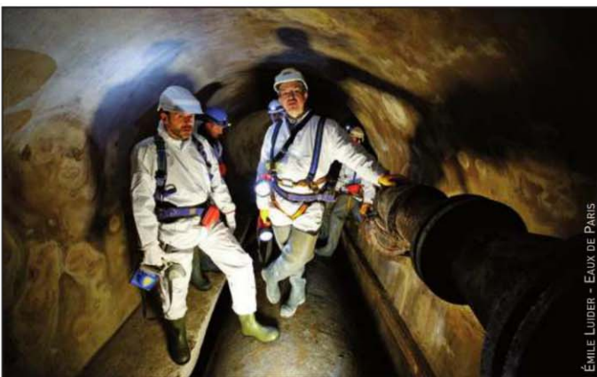
Figure 7. Le réseau est visitable à 90 % pour un linéaire de 2 050 km, dans un milieu néanmoins hostile pour le personnel
