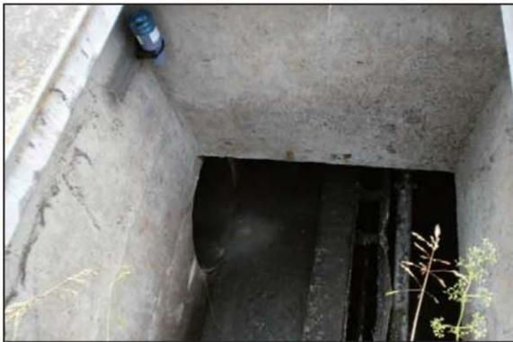
Figure 4. Sonde à ultrason installée dans un regard
