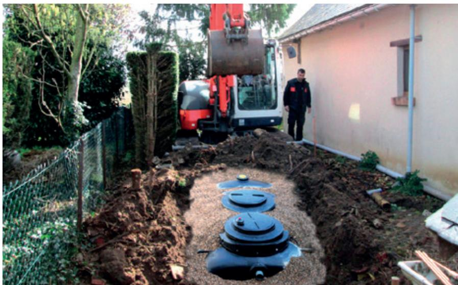
La microstation à cultures fixées Aquameris AQ2 de Sebico regroupe l'ensemble des fonctions du traitement dans une même cuve compartimentée: prétraitement, réacteur biologique et clarificateur.
