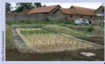
Deux mois de chantier ont été nécessaires pour la pose de 700 mètres linéaires de canalisations, essentiellement en gravitaire, 5 pompes de relevage, 4 dégrilleurs de 120 à 1000 litres, 1 station Hybrido 95 (OXY 50 + 45 m² de filtre phyto de 280 plantes).
