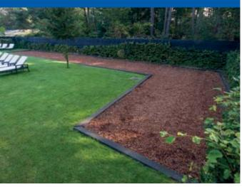
filtre compact dans son environnement. La présence d'un poste de relevage permet au Cocolit® de tamponer les eaux et d'anticiper les pics d'occupation ce qui en fait une solution adaptée aux applications touristiques. Le poste de relevage est géré par son armoire de commande qui limite la consommation d'énergie. La surface du lit filtrant se limite à 0,7 m² par habitant.
