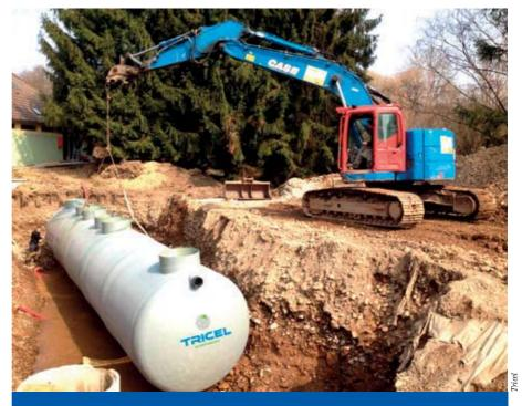
Tricel propose des microstations à cultures fixées pour le semi-collectif comparables aux installations individuelles jusque 60 EH et sur mesure entre 61 et 500 EH.
