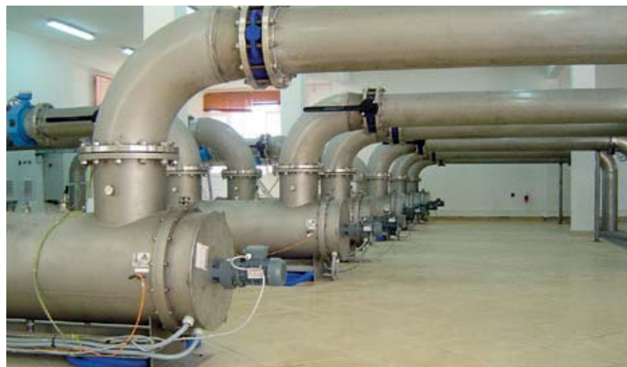
Station de traitement des eaux usées d'Agadir équipée d'un réacteur UV BIO-UV.
