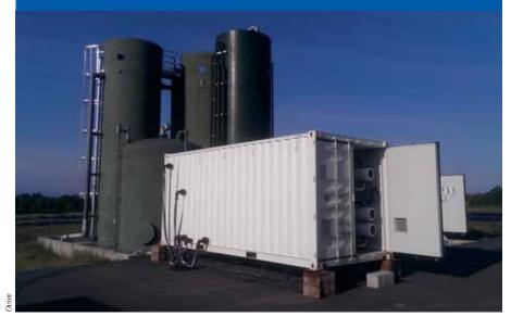
systèmes M-PAK, par SUEZ avec son système aquasource® UF Nomad, ou par Polymem avec son logiciel SoftMem, solution clé en main, livrée prête à être raccordée en 2 jours, pilotée à distance.
