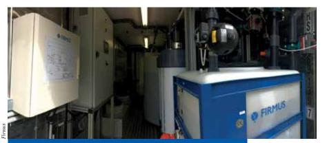
Firmus est capable d'accompagner collectivités et industriels depuis les essais de faisabilité au laboratoire (5 à 10 L/h) jusqu'à l'installation industrielle finale en passant par la mise en place de pilotes sur site pour validation (600 à 1000 L/h). Ceci permet de sélectionner la membrane d'ultrafiltration adaptée à la potabilisation de la ressource en eau du site et de dimensionner l'unité industrielle.
