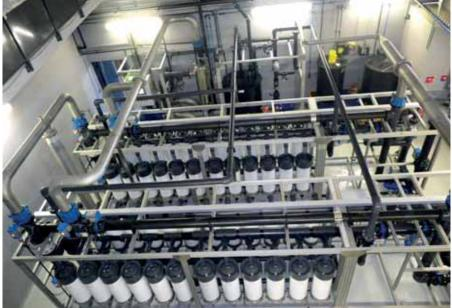
La Gamme Ultramem de Polymem est composée de modules fonctionnant en filtration en mode frontal Externe/Interne et offrant des surfaces de filtration de 4,5 à 114 m².
