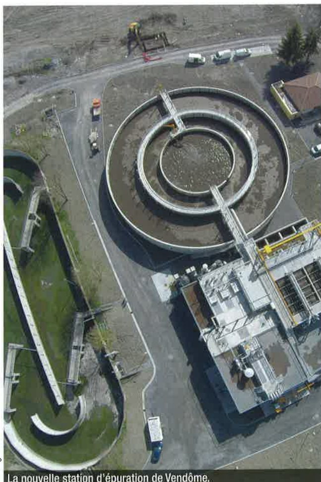
La nouvelle station d'épuration de Vendôme.
