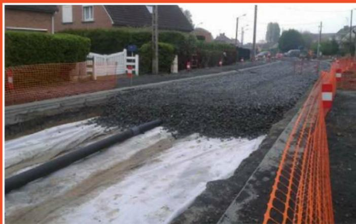
Mise en œuvre d'une chaussée réservoir dans le cadre d'une réhabilitation de voirie - CUINCY (59)
