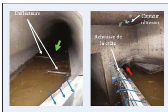
Figure 5. Aménagements effectués sur le déversoir La Pradelle (Clermont communauté) : à gauche vue des deux déflecteurs positionnés en amont, à droite vue de la rehausse de la crête (photographies : Thierry Dauge, Clermont communauté)
