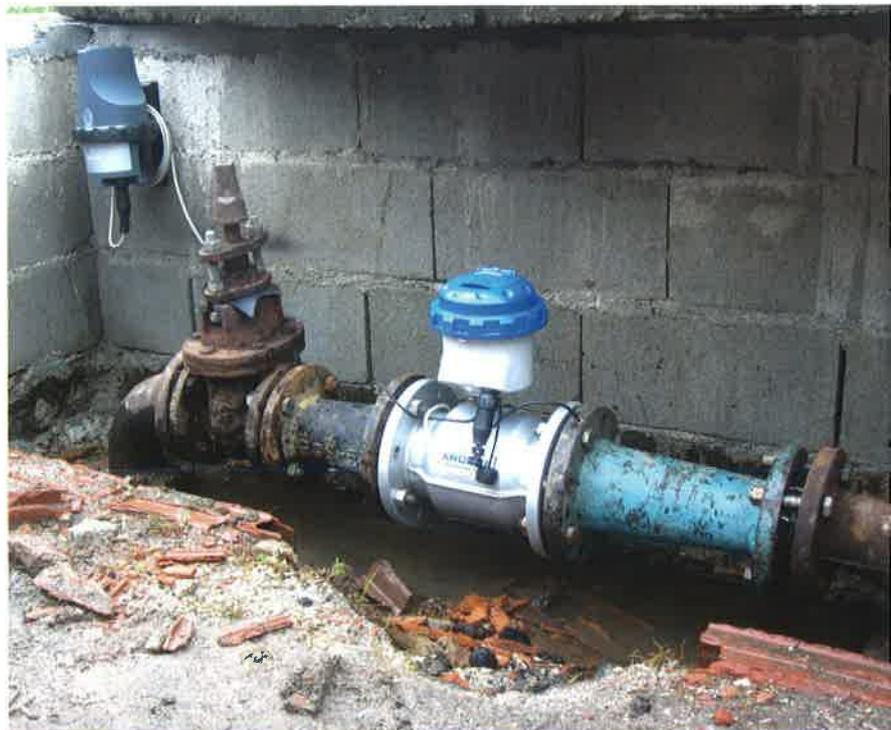
Autonome, communicant, le Waterflux de Krohne est bien adapté aux contraintes liées à la sectorisation. En plus de fournir une mesure précise du débit, cet appareil de mesure très compact, IP 68, possède un enregistreur de données et un module GSM.
