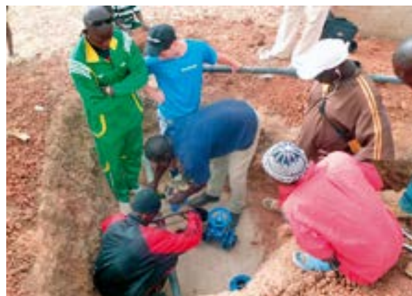
Chantier école supervisé par l'ADOS.
