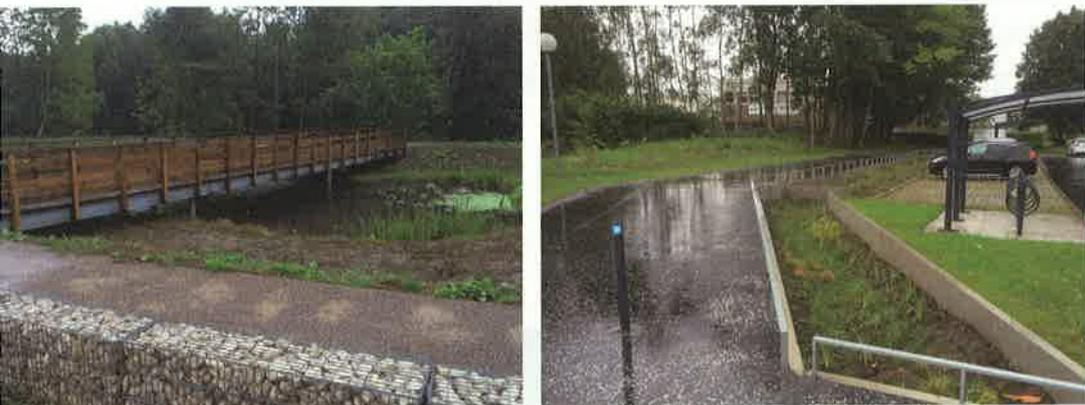
**Sur le campus de Mont-Huy** (59), la mise en œuvre de techniques alternatives permet de stocker et d'infiltrer près de 3 400 m<sup>3</sup> pour une pluie d'occurrence cent ans.
