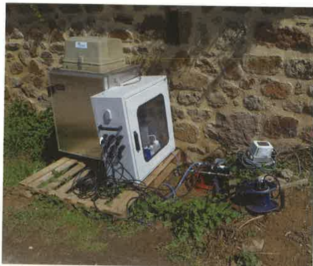
Un suivi national de l'efficacité des installations sur place a été lancé.
