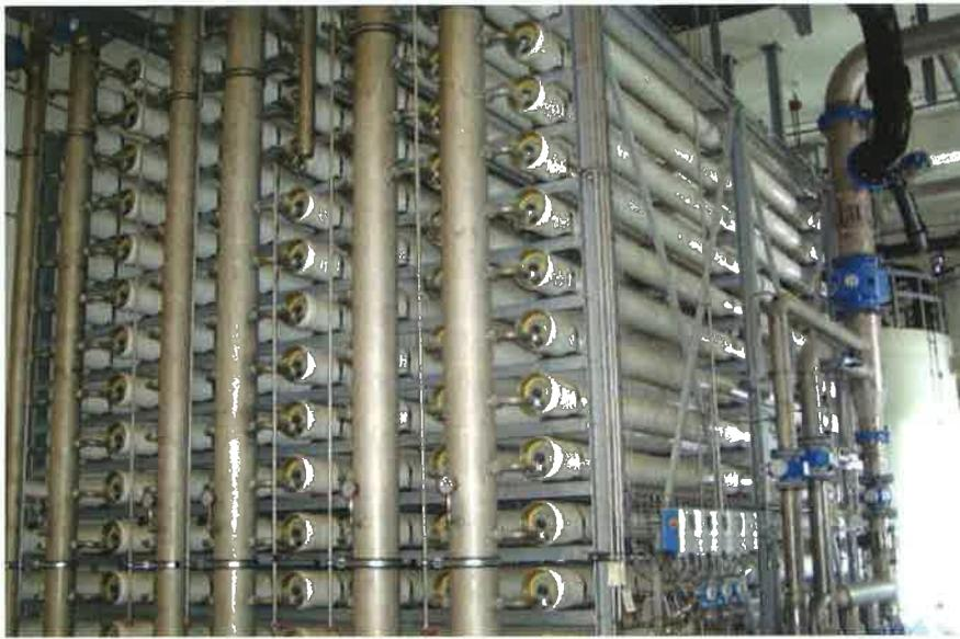
Une membrane de nanofiltration peut être assimilée à une cloison, une paroi, ou encore une barrière poreuse de très faible épaisseur capable, lorsqu'elle est interposée entre deux phases fluides, de contrôler le passage sélectif de matière (liquide, gaz, molécules, ions, ...) d'une phase vers l'autre.
