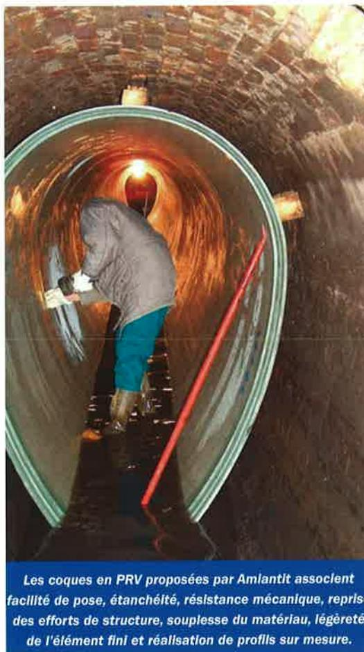
Les coques en PRV proposées par Amlantit associent facilité de pose, étanchéité, résistance mécanique, reprise des efforts de structure, souplesse du matériau, légèreté de l'élément fini et réalisation de profils sur mesure.
