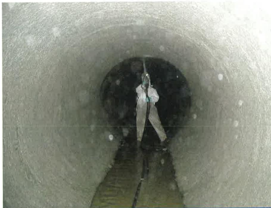
La méthode dite traditionnelle par voie humide consiste à décaper les enduits dégradés de l'ancien ouvrage puis, par injection ou collage, régénérer les éléments de maçonneries défectueux. L'intervention consiste ensuite à ancrer un treillis soudé sur les faces internes de l'édifice avant de projeter le nouvel enduit.
