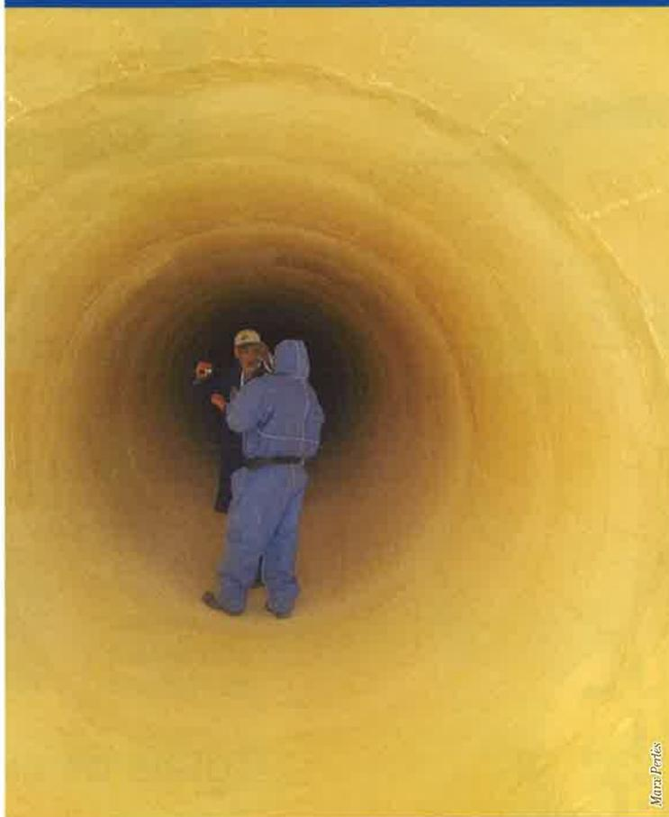
avant: l'imperméabilité du chemisage et l'intégrité de la couche de renfort demeurent excellents, le renfort structurel opérant.
