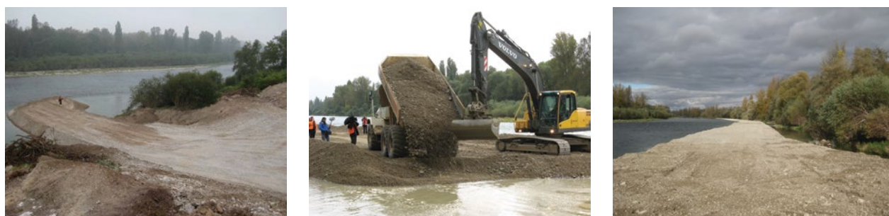
Figure 5 : Vues du chantier d'injection.
