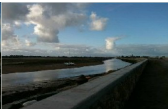
Illustration 9 : La jetée Jacobsen, après les travaux de consolidation et de rehausse menés par la CCN en 2011. [source : PAPI complet 2012 de l'île de Noirmoutier]
