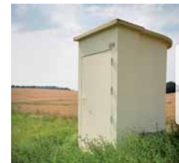
Regard permettant d'accéder à la galerie de l'aqueduc du Loing.
