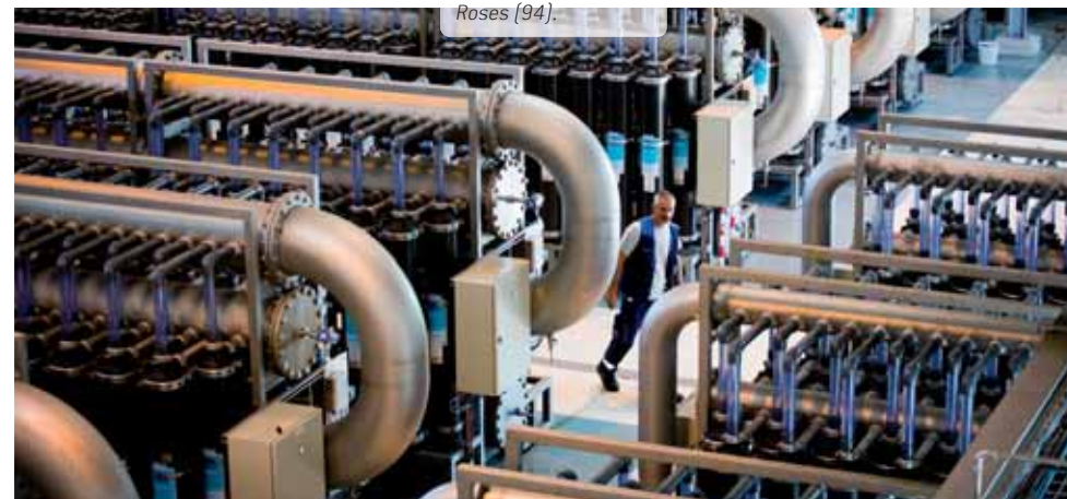
Dispositif de filtration de l'eau (membranes) à l'usine de L'Haÿ-les- Roses (94).
