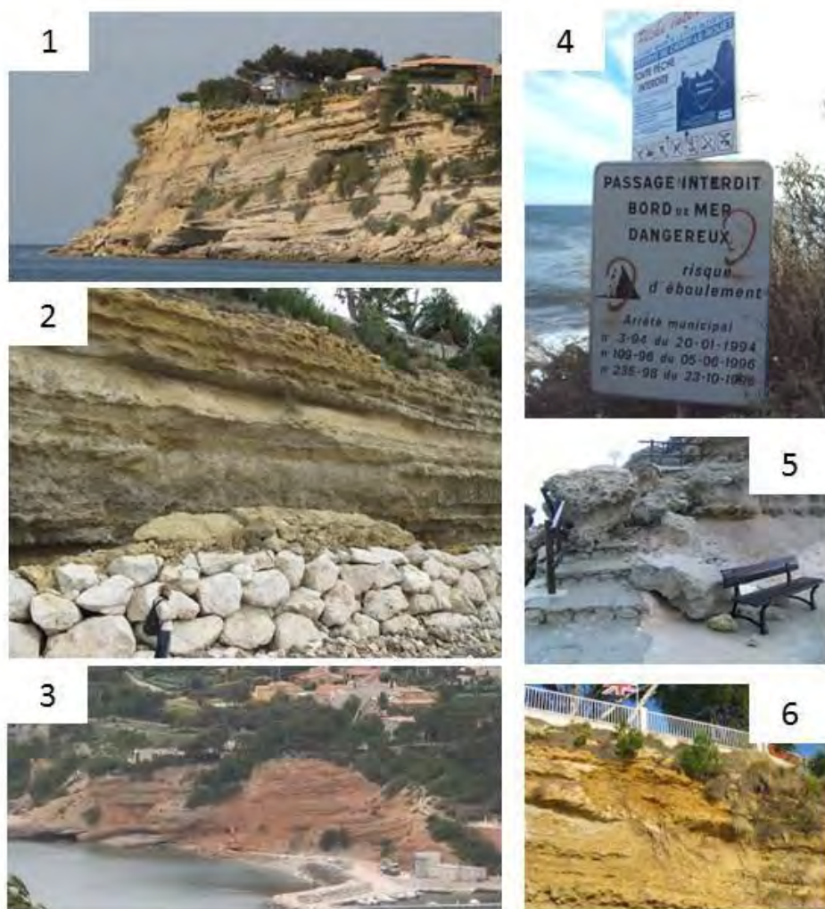
Figure 2 : Illustration du littoral de Carry-le-Rouet 1- Eboulement à Barqueroute le 13 février 2008 de 500 m 3 ; 2- Eboulement de 150 m 3 au Port de Carry (partie Est) en 2013 ; 3- Travaux suite à l'éboulement d'avril 2005 au Port du Rouet ; 4- Arrêté municipal au niveau du Cap Rousset interdisant l'accès ; 5- Eboulement au Port de Carry (sentier du Léopard) le 15 décembre 2008 affectant les escaliers du sentier du littoral ; 6- Eboulement au Port de Carry (partie Est) le 6 février 2008 de 5 m 3 (Photos © BRGM).
