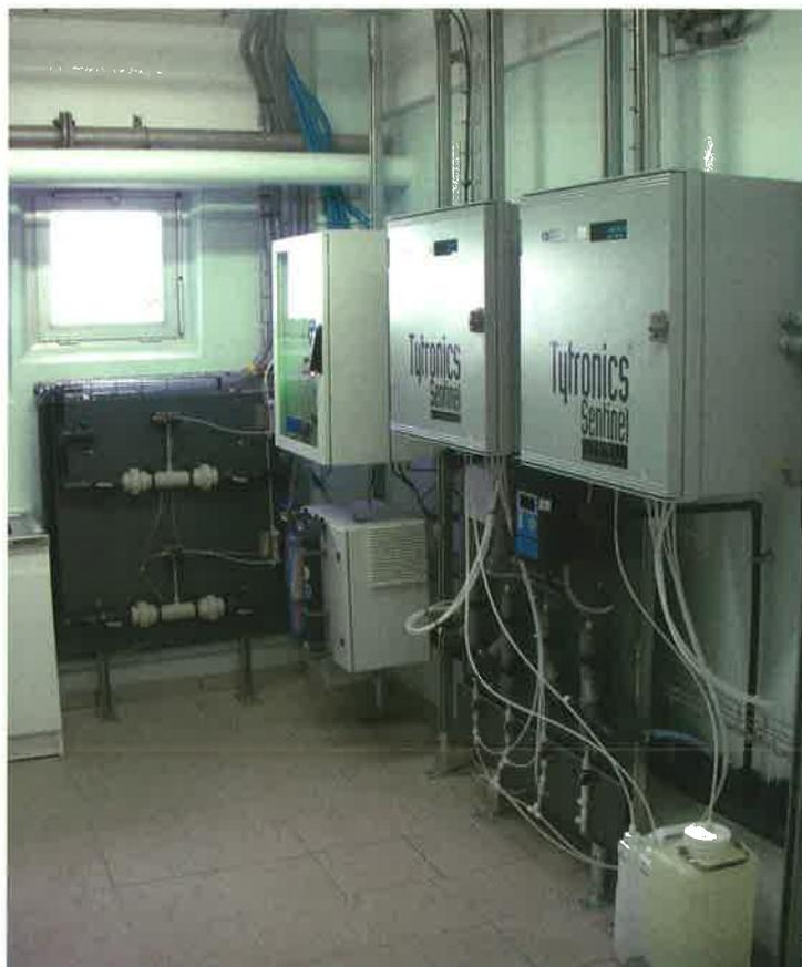
Anael propose notamment le suivi en ligne du COT, de la turbidité, des hydrocarbures, du TAC et de certains ions métalliques (Fer, Manganèse, Aluminium, etc...). Les mesures en continu dans les usines d'eau potable permettent de suivre au plus près la qualité des eaux tout au long du traitement, depuis l'eau brute en entrée de station jusqu'à l'eau distribuée sur le réseau, afin d'ajuster avec une réactivité maximale les traitements, garantissant ainsi une sécurité optimale au consommateur.
