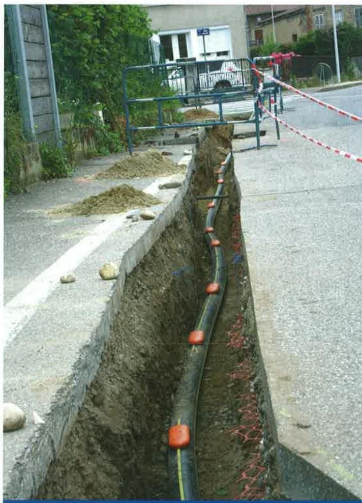
La société ELIOT Innovative Solutions propose un système de détection 100 % RFID (de la détection à la gestion de l'information) permettant de géolocaliser précisément tout type d'ouvrage enterré et surtout offre la possibilité de géoréférencer, fouille fermée.
