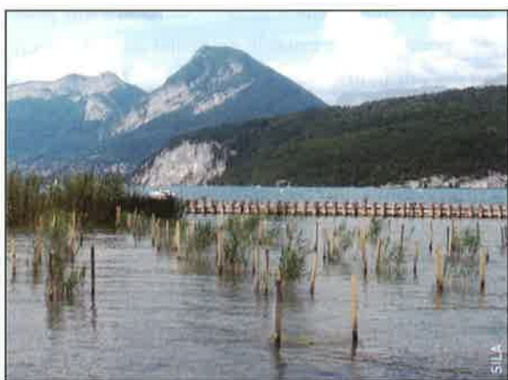
Figure 8. Plantations de roseaux à l'arrière d'un ouvrage anti-houle
