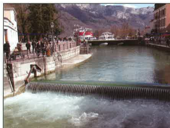
Figure 4. Vanne de régulation du lac, située à l'entrée de l'exutoire (le Thiou), dans la ville d'Annecy
