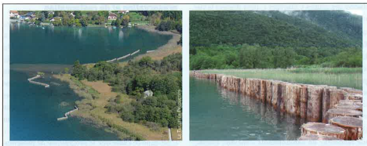
Figure 5. Site pilote du « Bout du lac » à Doussard. Vue générale et détaillée des ouvrages de protection
