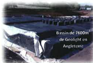
Bassins enterrés pour stockage des eaux pluviales
