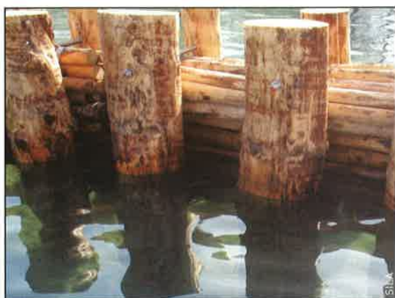
Figure 6. Ouvrage de type « fascine imputrescible ». Site pilote du « Sentier des roselières » à Saint-Jorioz
