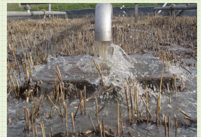
Bâchée envoyée sur roseaux faucardés
