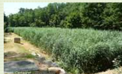
Filtre Planté de Roseaux
