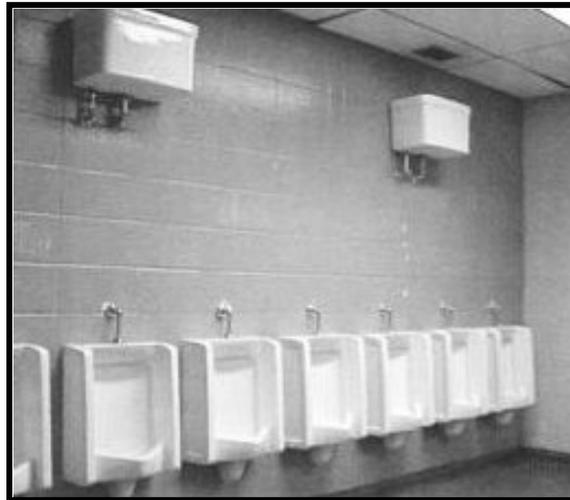
Les urinoirs à chasse périodique devraient être remplacés par des modèles à chasse manuelle ou par des modèles munis d'un œil magique. À défaut de leur remplacement, l'intervalle de chasse d'eau dans les urinoirs de type périodique devrait être ajusté à 10 minutes au minimum. De plus, leur alimentation devrait être fermée lorsque l'établissement est lui-même fermé. Le tableau 4-1 illustre la consommation d'eau typique des urinoirs à chasse automatique pour différentes conditions.
