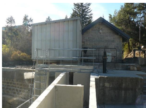
Photos n°20 et 21 : Photos après travaux avec la nouvelle passe à bassins successifs de l'usine de la Cassagne avec la prise d'eau de la Salitte (Perrin J-A, 2015)
