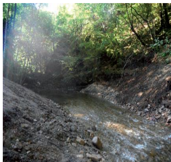
Photo n°16 : Vue aval du site après-travaux en 2013 (SMPVD)
